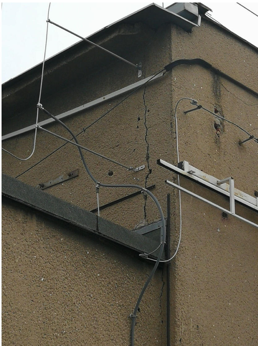
Obr.15 – trhlina v obvodovom murive
