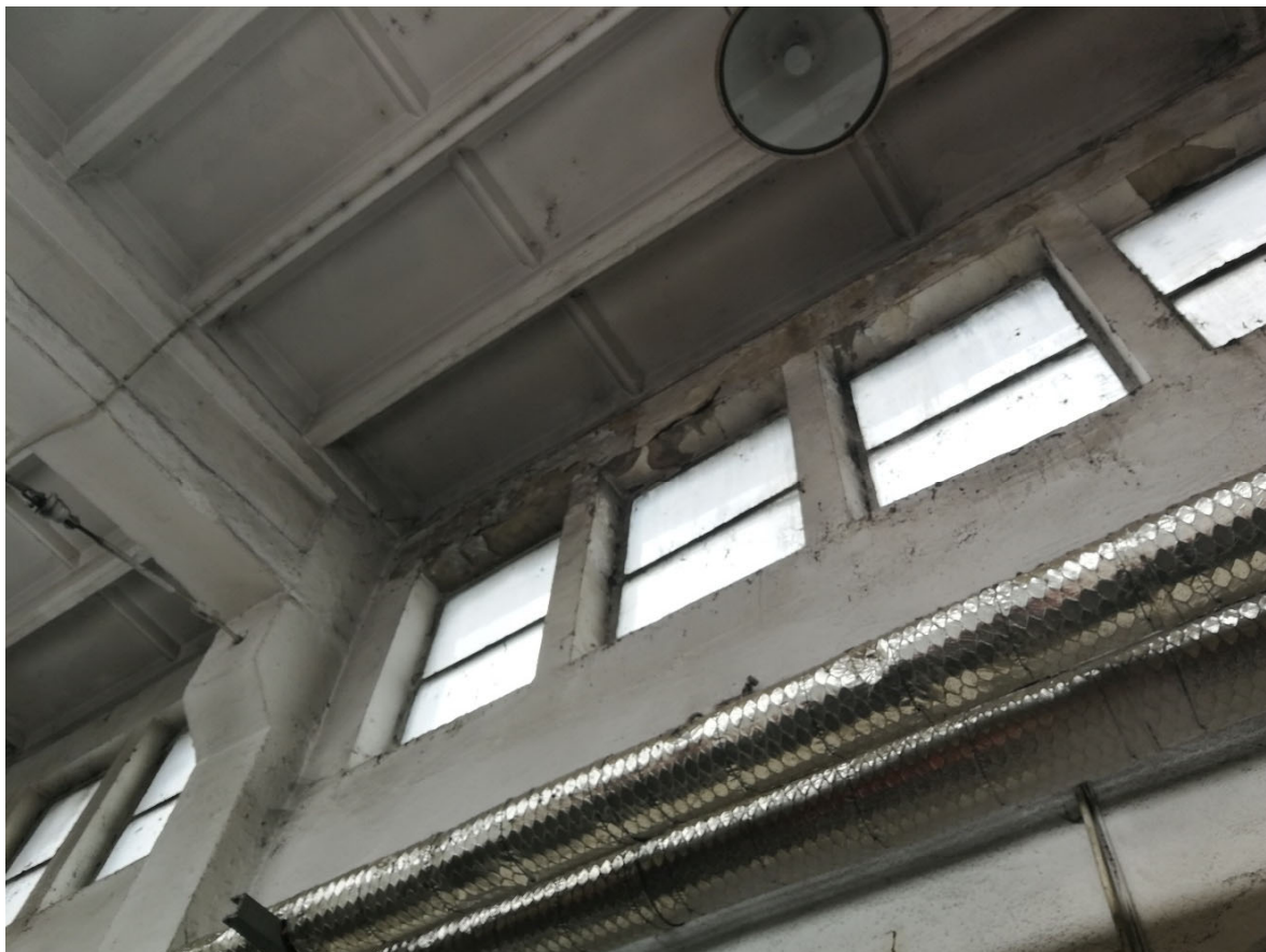
Obr.14 – karbonatácia v dôsledku zatekania
