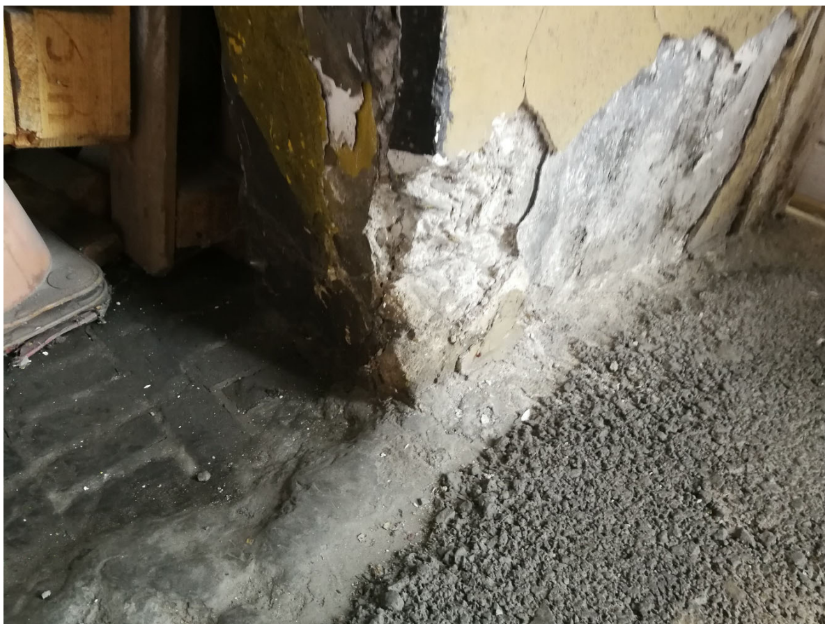
Obr.13 – rozpad betónu v dôsledku vzliňania + nárazov vozidiel
